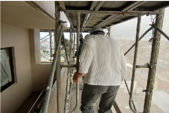
修繕委員会の足場解体前検査
