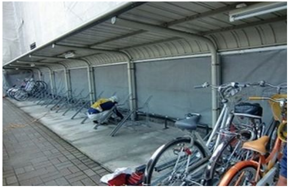
既設駐輪場でのスライド式ラックへの取替え工事
