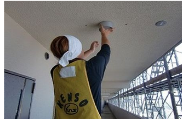
共用廊下のLEDランプへの取替え工事
