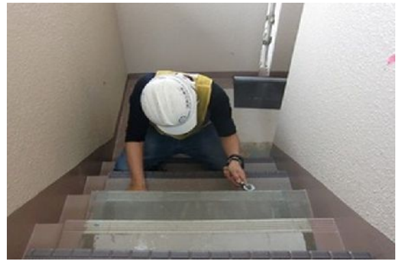
外部階段の塩ビシート貼り工事
