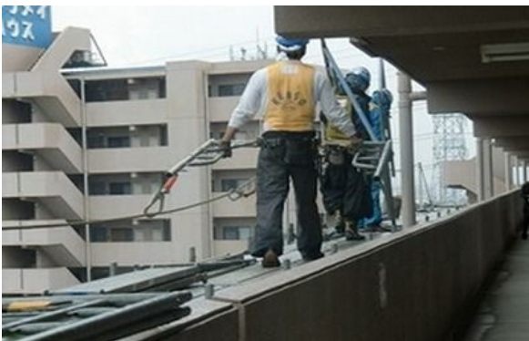
足場組立工事
