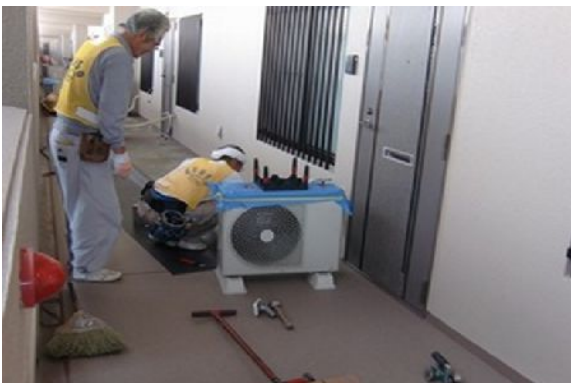
共用廊下の塩ビシート貼り工事
