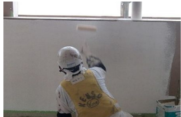
共用廊下の塗装工事
