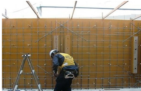
花壇解体後の駐輪場新設型枠工事
