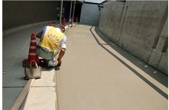
新設駐輪場の床面仕上
