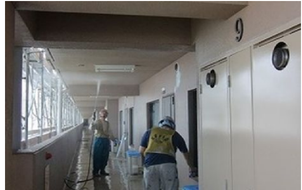
共用廊下の高圧洗浄作業
