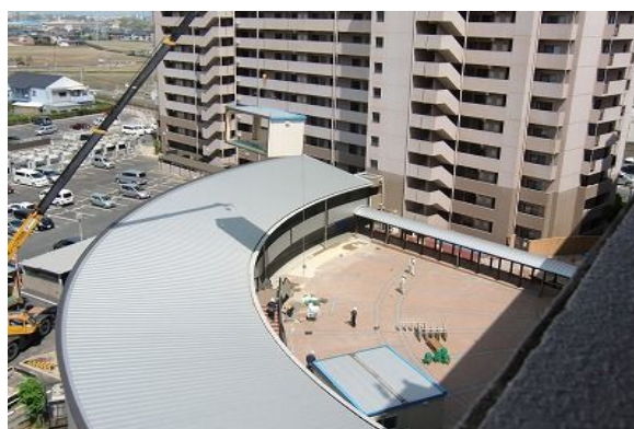
現場事務所の搬入
