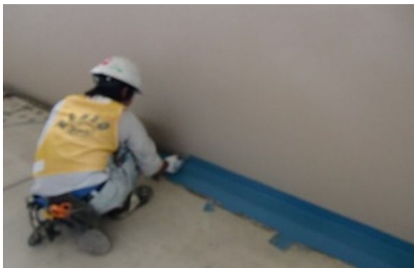
共用廊下の防水工事
