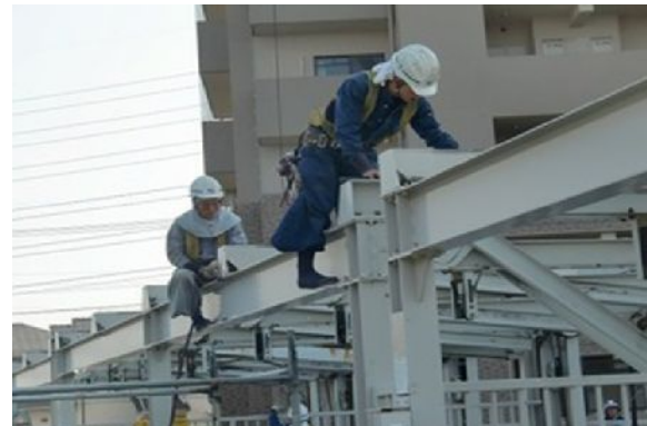
機械式駐車場解体工事
