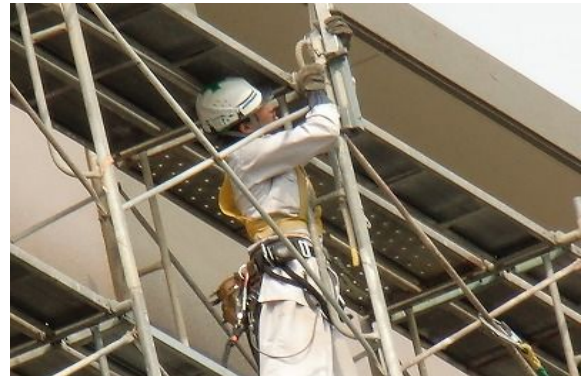
足場組立工事
