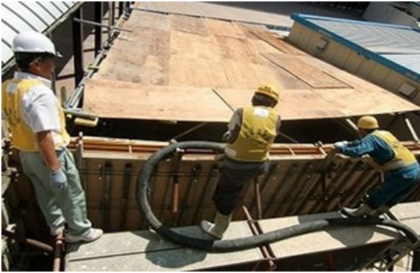
新設駐輪場のコンクリート打ち工事
