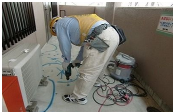
共用廊下の床面補修工事
