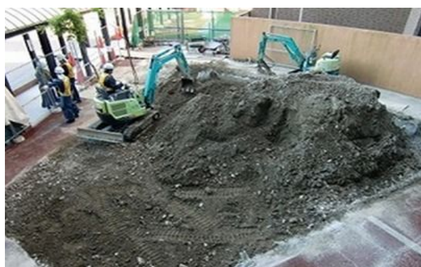
プレイロットの解体工事
