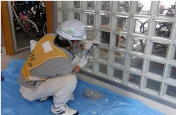
共用館1階通路のガラスブロック補修工事
