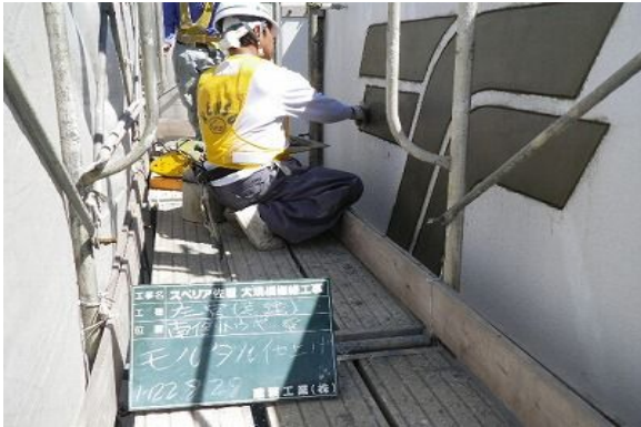
屋上看板の旧文字塗り込み
