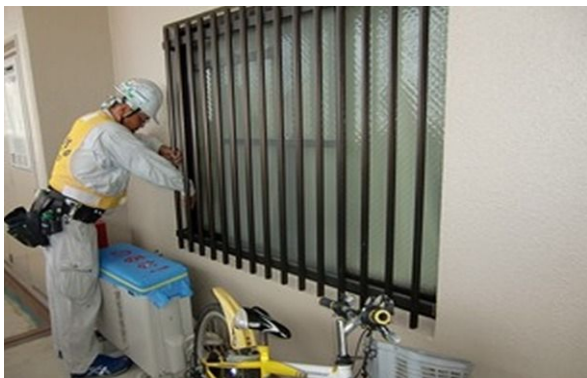
共用廊下の格子取り外し工事
