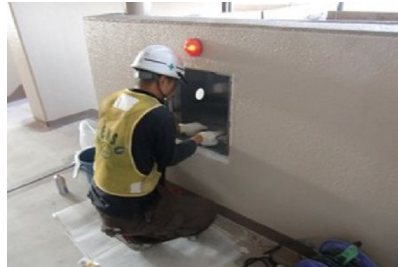
消防隊専用消火栓ボックスの取替え
