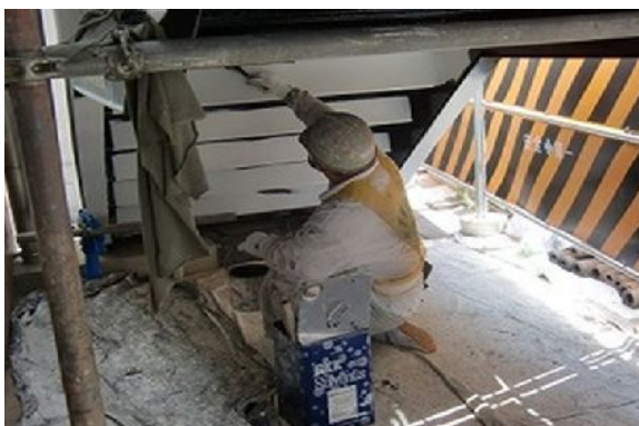
共用館階階段裏側の塗装工事
