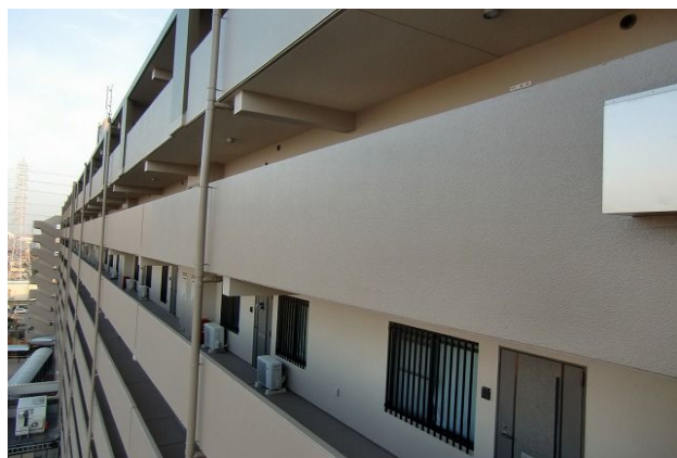
共用廊下壁面
