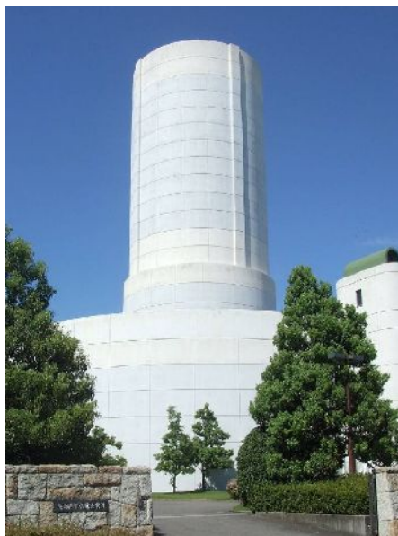
弥富インター付近の配水塔
