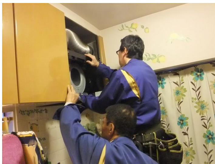
取付け工事中
