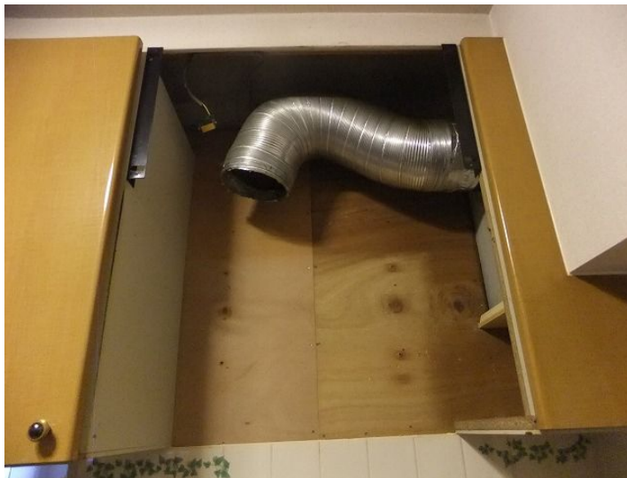
レンジフード 撤去後の状態
