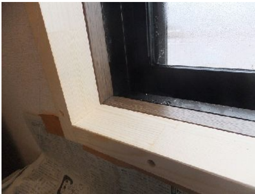
取付けた「ふかし窓」
