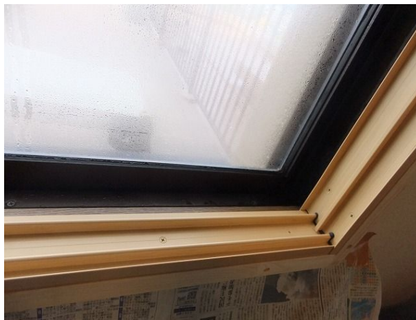
樹脂製の窓枠取付け済
